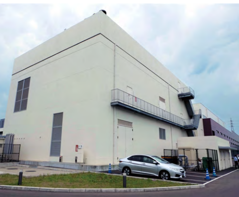
エネルギーセンター棟(外観)
