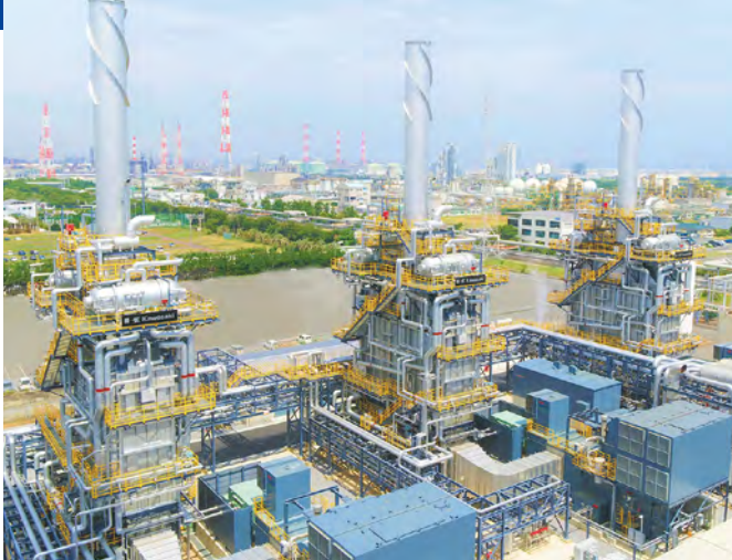
32.3MWガスタービンコージェネ3台などを利用したコンバインドサイクル発電プラントを導入。鹿島東部コンビナート内の熱電需要の変化に対応し電気と蒸気を最適に供給、28%のプラント総合効率改善を達成した
