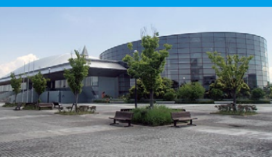
P.8 新潟市 亀田総合体育館
