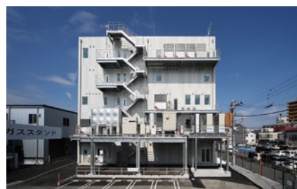
バルコニーに設置されたガスコージェネなどの機器類は「見える化」の効果も
