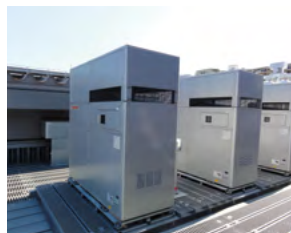
ガスエンジン・コージェネ（35kW×3台）
